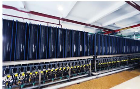
业主经过全国考察和技术评比，2020年5月最终采用烟台金正环保CDRO膜系统，替换原有双膜系统。经过一年的稳定运行，膜系统化学清洗周期延长至1次/月，回收率达80%以上，运行成本整体降低45%，彻底解决焦化废水处理难题，保障了企业稳定生产，业主方对一期运行结果非常满意。2021年，在项目二期中，业主又增购2套CDRO膜设备。
